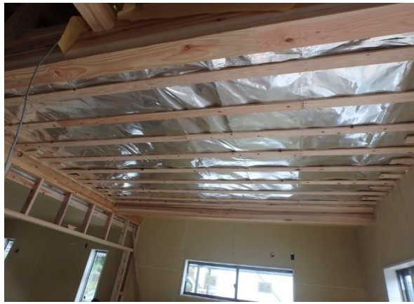
遮熱シート施工例(天井)
