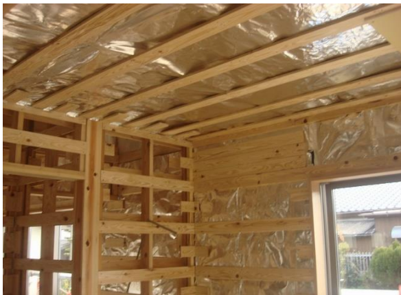
遮熱シート施工例(壁・天井)
